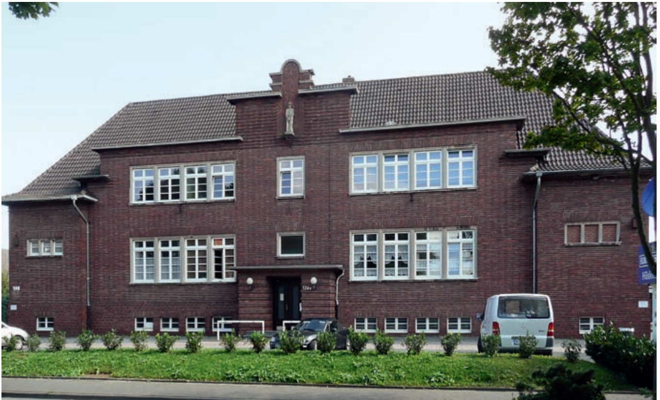
26. Viersen-Dülken, Bodelschwingstraße 126, ehem. Landwirtschaftsschule. Foto: Marco Kieser, LVR/RD, 2008.
